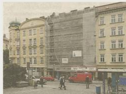
Noch verdeckt ein Gerüst die Fassade am Wiener Platz.
